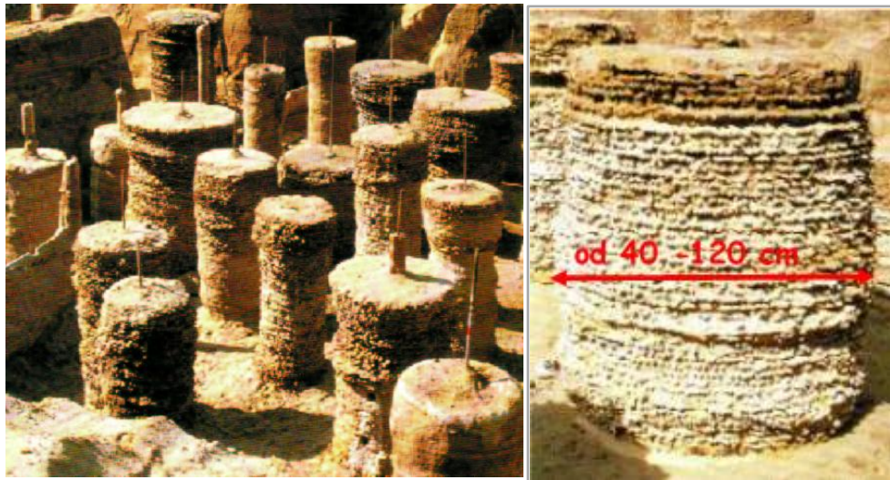
Sl.53:- Izgled i prečnik injektiranog stuba - valjka
