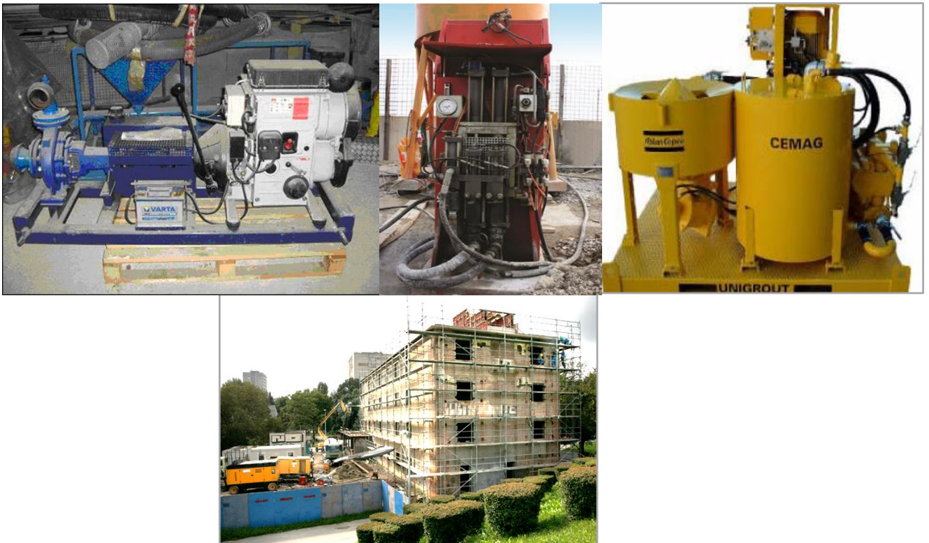
Sl.92:- Injekciona platforma - pumpa za injektiranje sa pratećom opremom istatičko ojačanje zidova izvedeno mlaznim betonom
