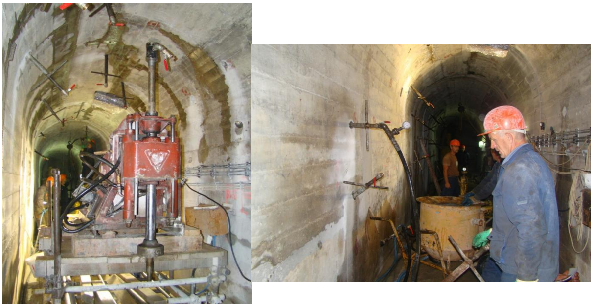
Sl.77:- Injektiranje: primer kontaktnog injektiranja tunela
