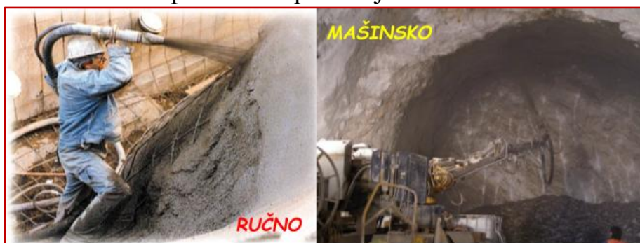
Sl.97:- Ručno i mašinsko nanošenje mlaznog betona
