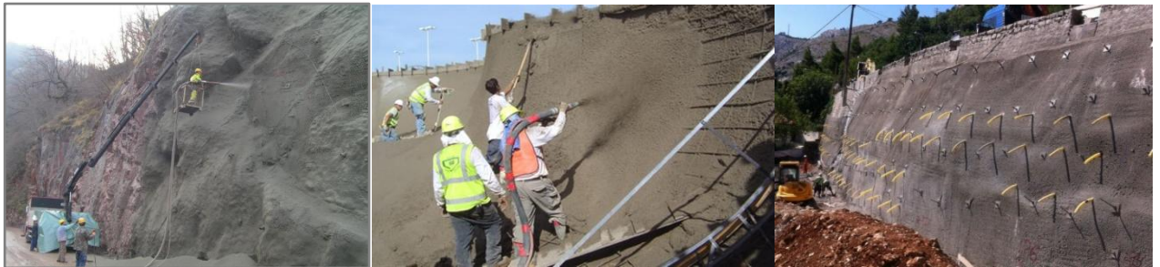
Sl.102:- Ugradnja torkreta
