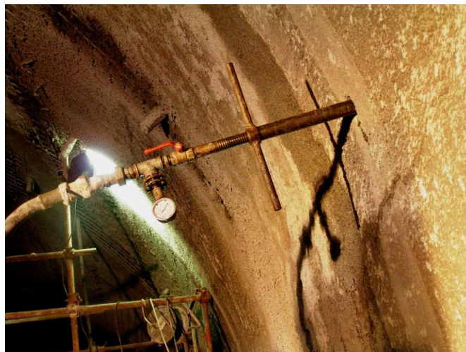
Sl.82:- Tunel i zona kontaktnog injektiranja
