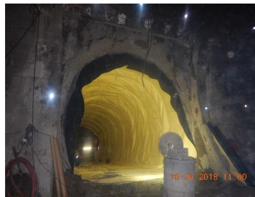
Figura 9. Tratamiento de impermeabilización con geotextil y geomembrana, referencia 3.
