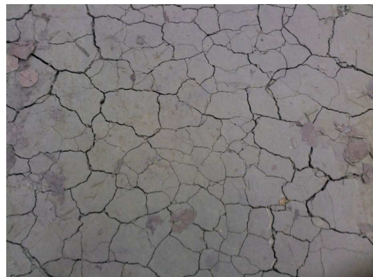
Figura 1 - Tipica fessurazione da ritiro in terreni di natura argillosa
