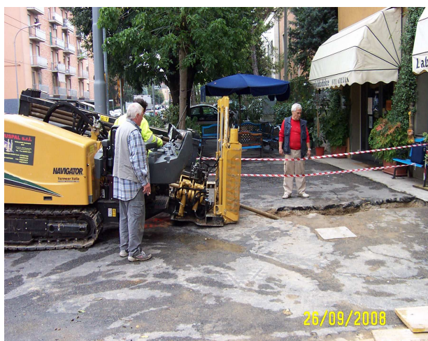
Figura 10 – Realizzazione delle perforazioni “No Dig”
