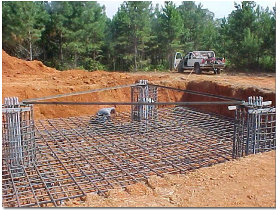
Foto 11: Montimi i prizhonierave perpara betonimit
