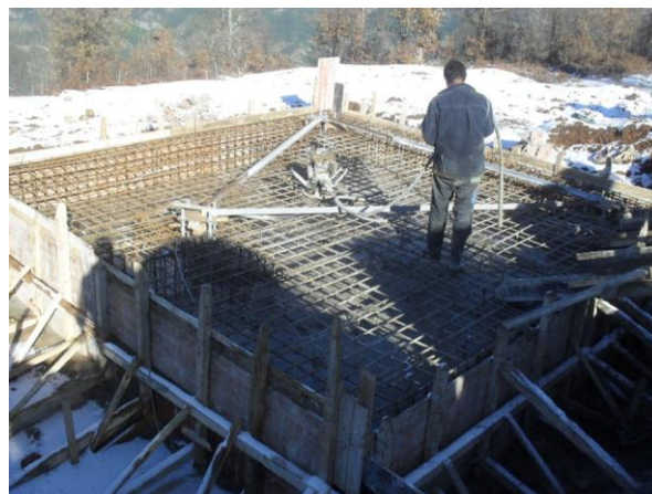
Foto 14 : Betonim në kushte të temp. të ulëta
