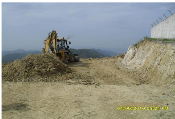
Foto 5: Gjate germimit per bazamentin e kules,Durres
