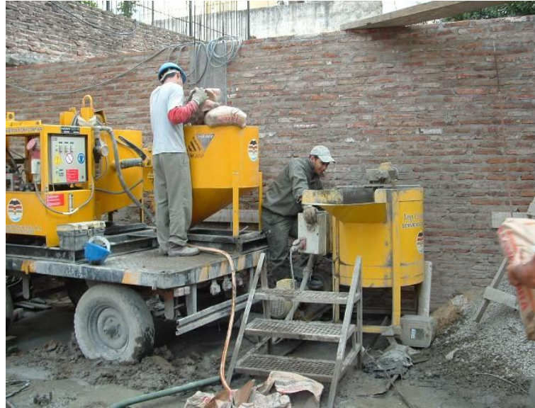
Figura N° 35: Equipos de inyecciones trabajando en obra
