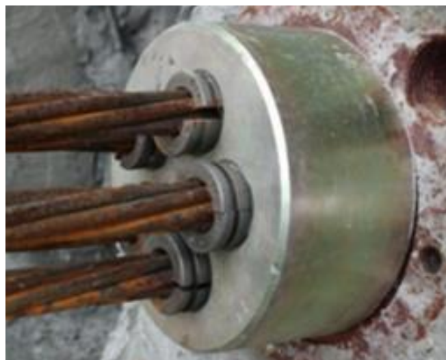
Figura N° 81: Cabezal de anclaje de cuatro cordones
