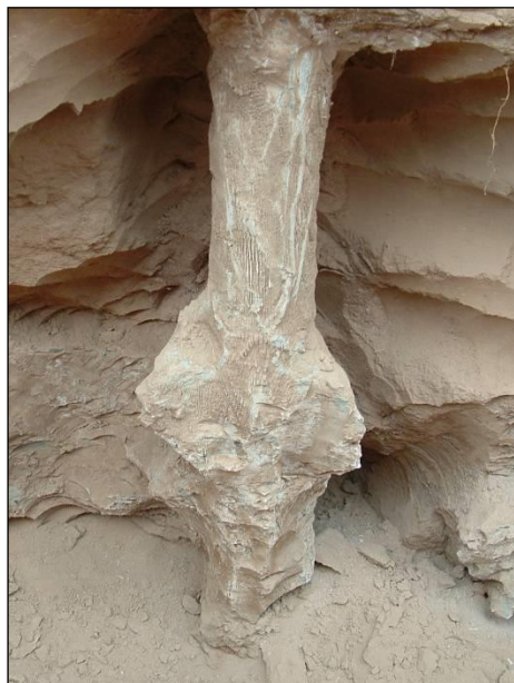
Figura N° 36: Manguito inyectado y excavado de un micropilote de 0,15 m de diámetro
