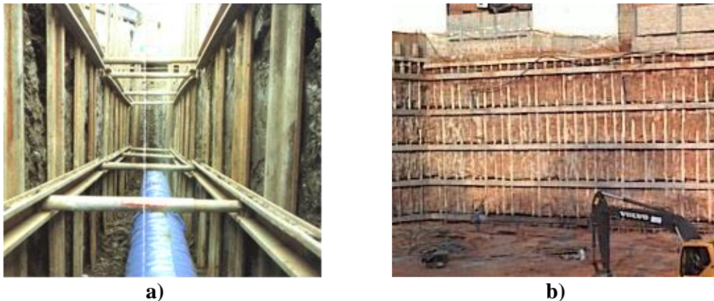
Figura N° 53: Entibamiento parcial en suelos cohesivos
