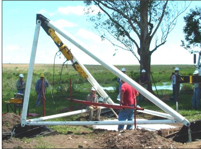
Figura N° 45: Marco de carga para ensayos en anclajes inclinados
