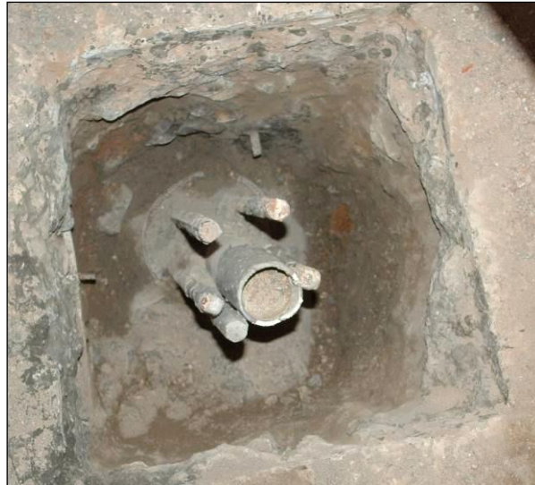
Figura N° 37: Micropilote terminado
