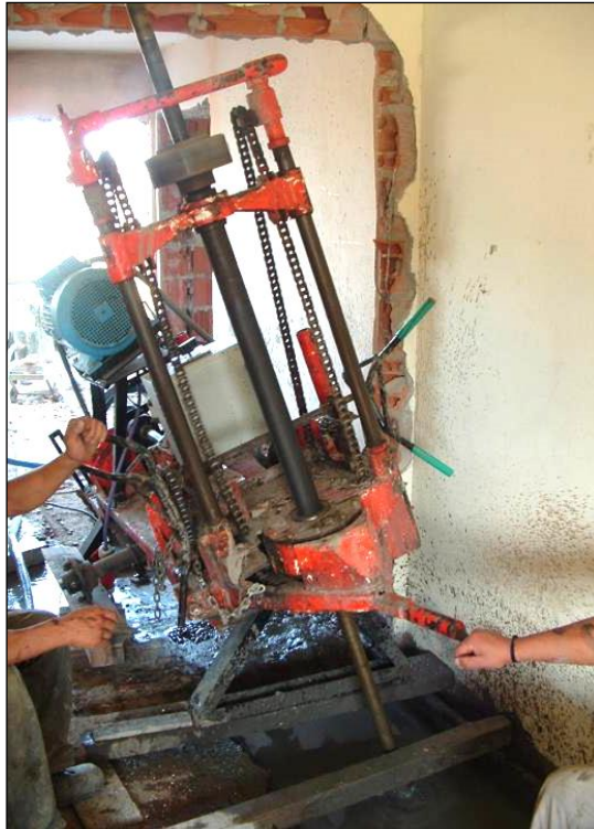
Foto N° 22: Construcción de un micropilote en espacios reducidos para la submuración de un edificio
