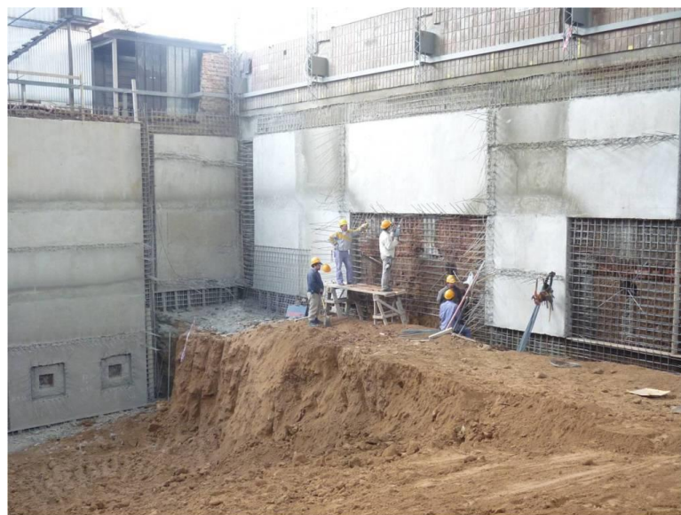
Figura N° 69: Construcción de tabiques y anclajes
