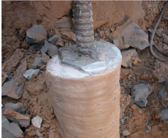
Figura N° 11 b: Micropilote terminado ejecutados con el sistema IGU
