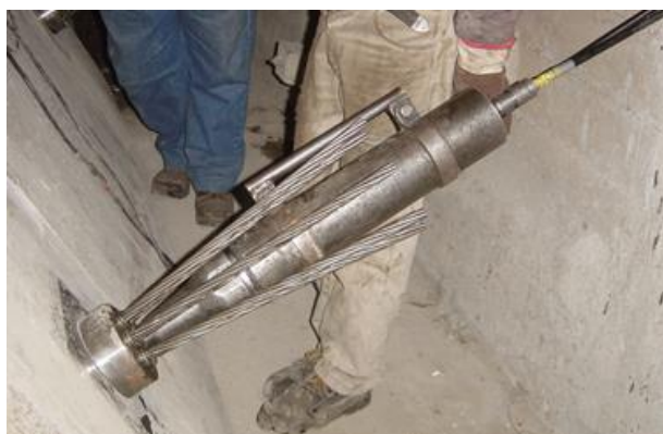
Figura N° 82: Gato hidráulico para el tesado de los mismos
